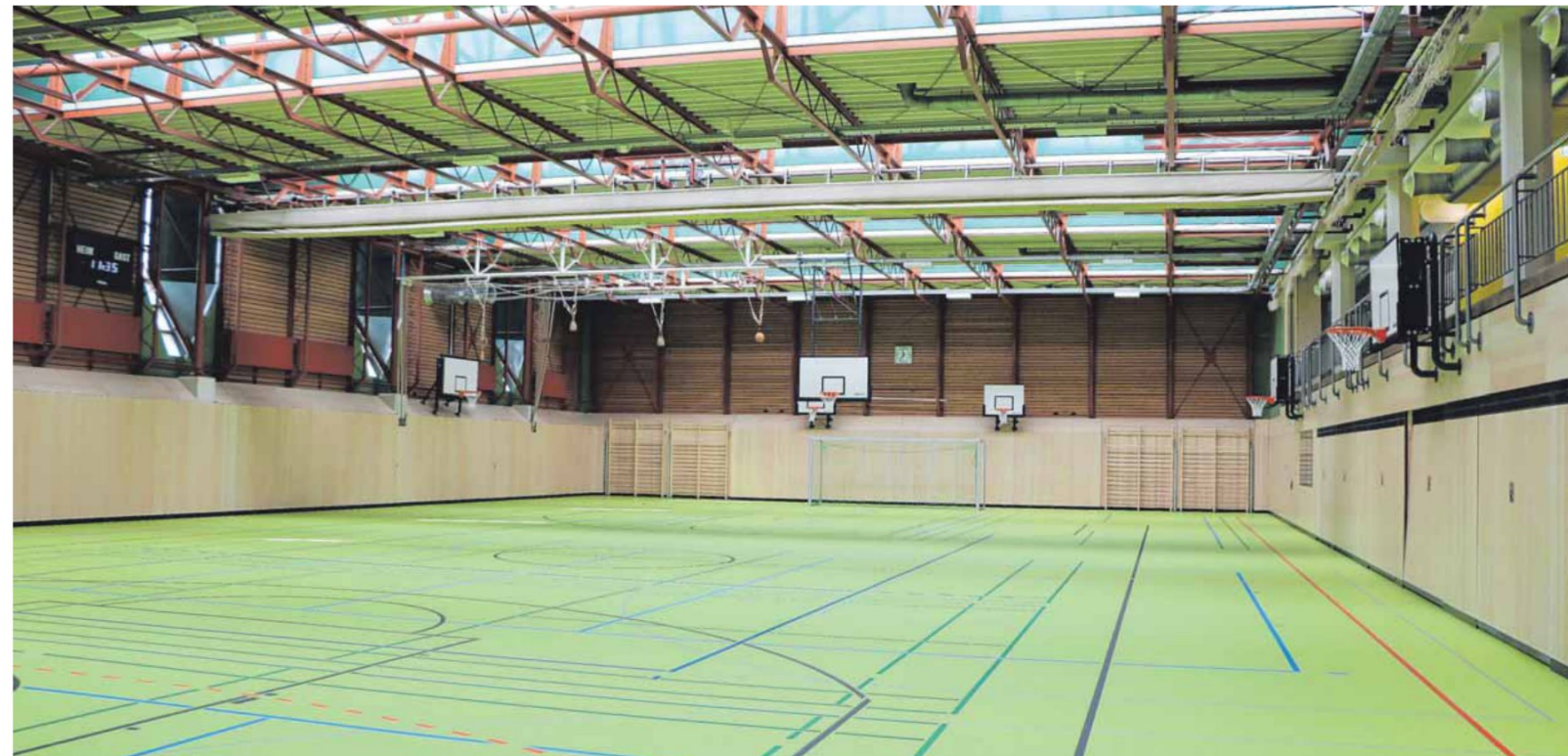
So leer ist es derzeit nicht: Die Kreissporthalle bei der Geschwister-Scholl-Schule wird derzeit als Behelfsunterkunft für Kriegsflüchtlinge genutzt. Für Sportvereine und Schule fällt die Halle damit als Trainingsort weg.
